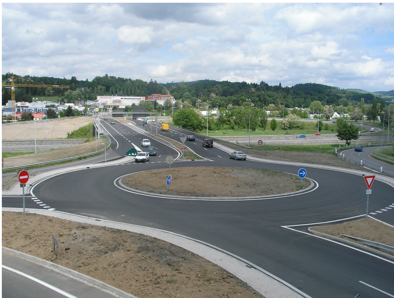
Le nouveau giratoire sur la RD 201, du côté de Villars
